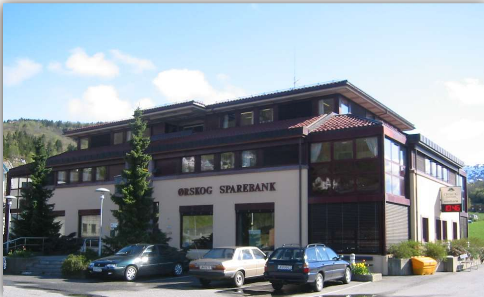
Ørskog Sparebank flyttet inn i eget administrasjonsbygg i Sjøholt sentrum i 1990.
